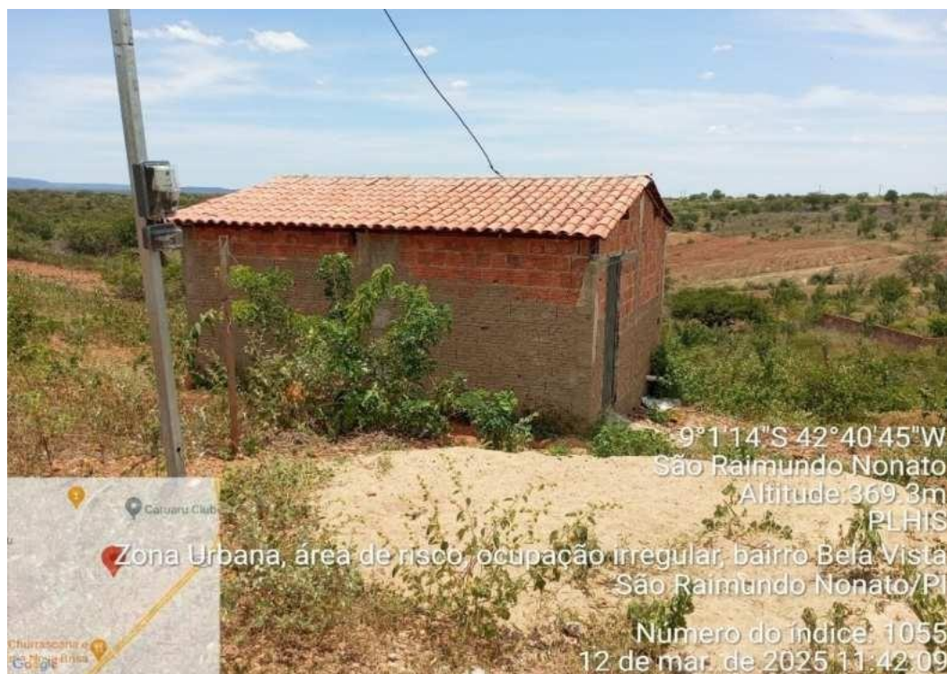
Foto 29 - Casa construída em área de risco e ocupação irregular, no bairro Bela Vista/02. Fonte: Autores do PLHIS (2025).
