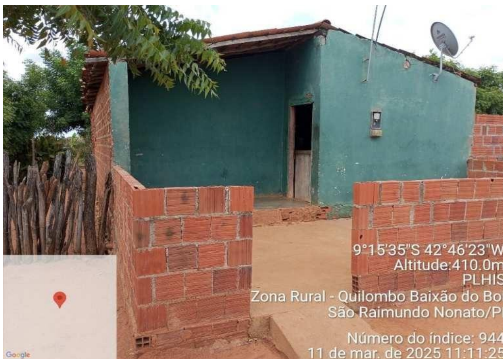
Foto 79 – Residência precária no Quilombo Baixão do Boi. Fonte: Autores do PLHIS (2025).
