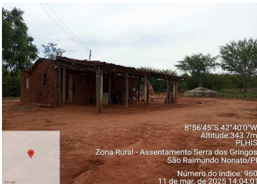
Foto 43 – Residência precária no Assentamento Serra dos Gringos/01. Fonte: Autores do PLHIS (2025).
