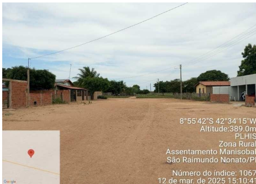
Foto 59 - Aspecto social do Assentamento Manisobal. Fonte: Autores do PLHIS (2025).
