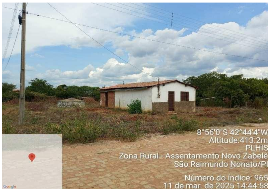
Foto 45 - Residência com Cisterna Telhadão para captação e reservação de água. Fonte: Autores do PLHIS (2025).
