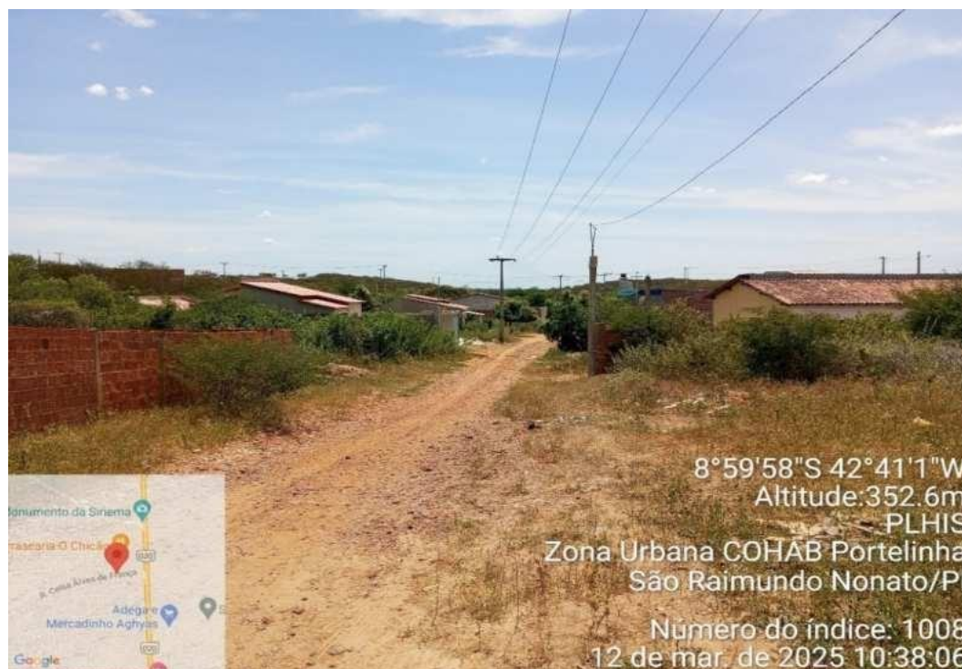
Foto 16 - Conjunto Habitacional COHAB Portelinha, ruas sem pavimentação asfáltica. Fonte: Autores do PLHIS (2025).
