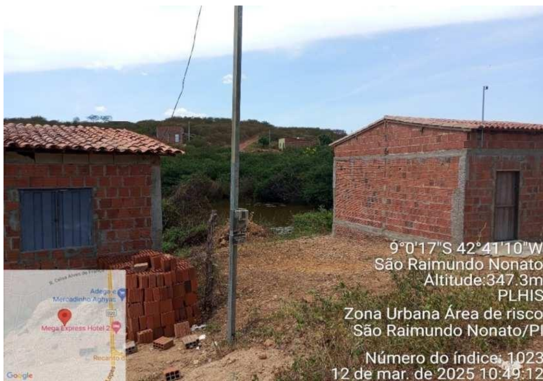
Foto 12 - Construção em área alagáveis, margem de rio- Coordenadas geográficas: 9°0'17"S/42°41'10"W. Fonte: Autores de PLHIS (2025)
