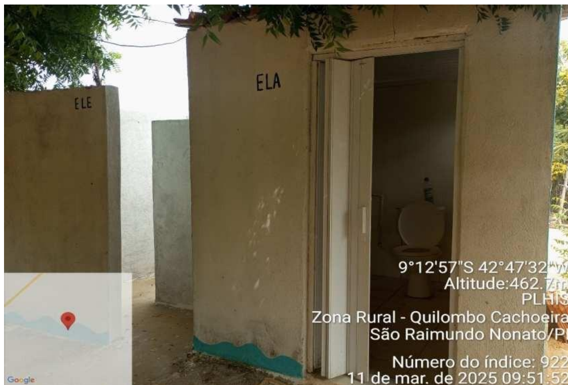
Foto 92 - Banheiro residencial no quilombo Queimada Cachoeira, com alguns dispositivos sanitários
