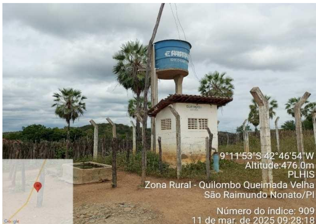
Foto 65 - Poço tubular e reservatório no Quilombo Queimada Velha. Fonte: Autores do PLHIS (2025).
