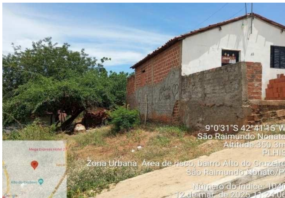
Foto 10 – Casa construída em área de risco, no bairro Alto do Cruzeiro. Fonte: Autores do PLHIS (2025).
