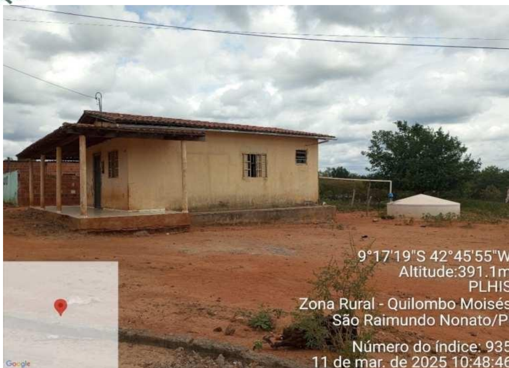
Foto 77 – Residência precária com Cisterna Telhadão para captação e reservação de água no Quilombo Moisés.
