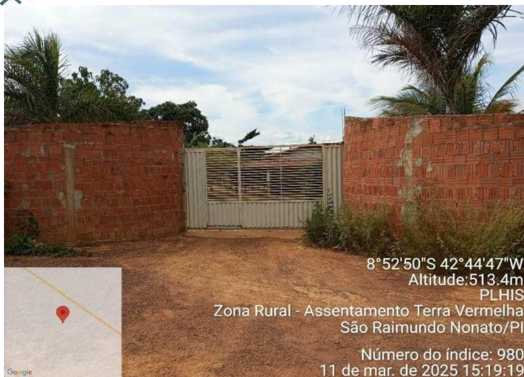
Foto 57 - Habitação com melhorias na infraestrutura no Assentamento Serra Vermelha. Fonte: Autores do PLHIS (2025).
