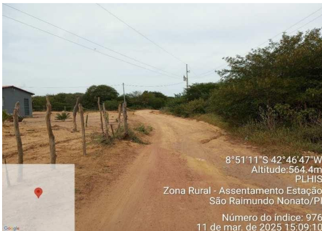
Foto 52 - Assentamento Estação, sem calçamento. Fonte: Autores do PLHIS (2025).
