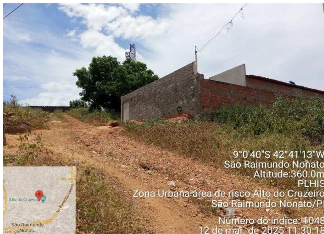
Foto 36 - Casa construída em área de risco, no bairro Alto do Cruzeiro/02. Fonte: Autores do PLHIS (2025).
