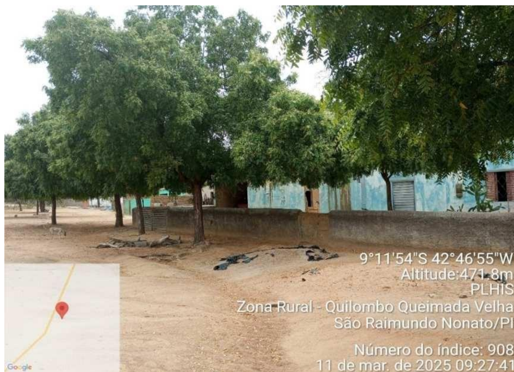
Foto 64 – Residências do Quilombo Morada Velha, com ausência de calçamento. Fonte: Autores do PLHIS (2025).
