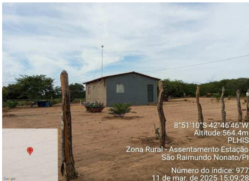
Foto 53 - Habitação precária no Assentamento Estação/01. Fonte: Autores do PLHIS (2025).
