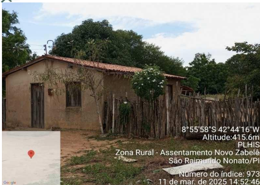
Foto 51 – Habitação precária no Assentamento Novo Zabelê. Fonte: Autores do PLHIS (2025).
