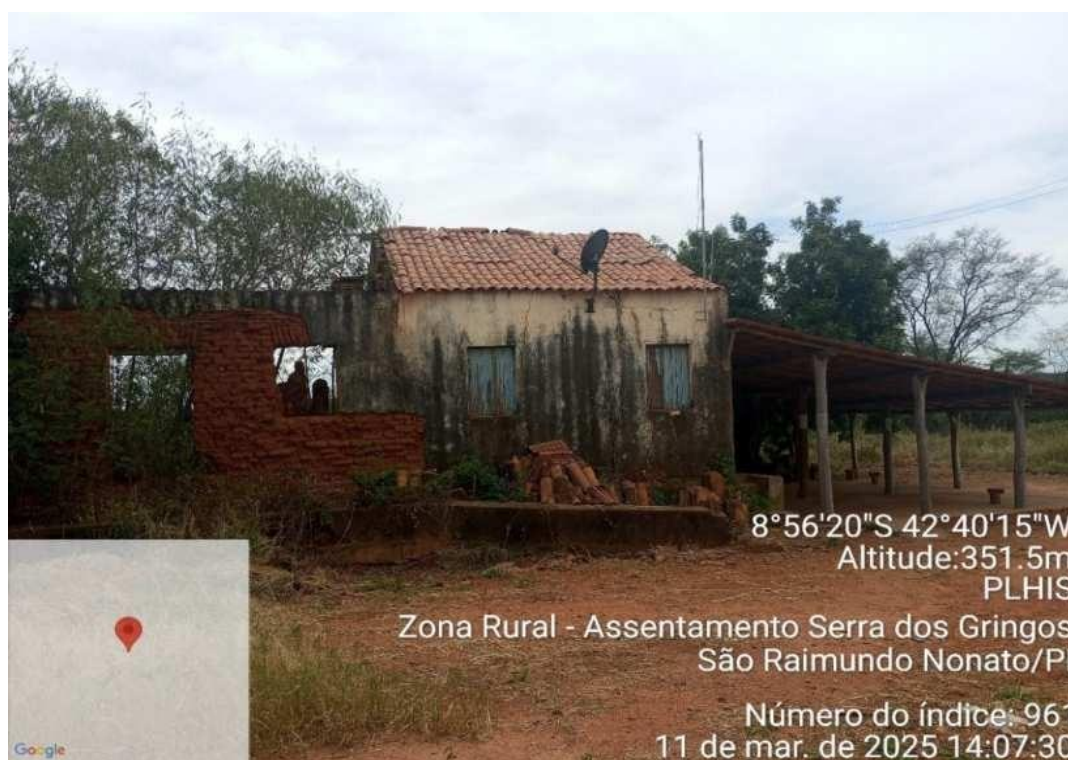
Foto 88 - Habitação precária no Assentamento Serra dos Gringos. Coordenadas geográficas 8°56'20=S/42°40'15=W.
