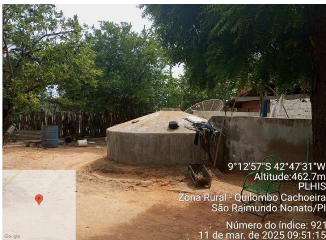
Foto 70 – Residência com Cisterna Telhadão para captação e reservação de água. Fonte: Autores do PLHIS (2025).
