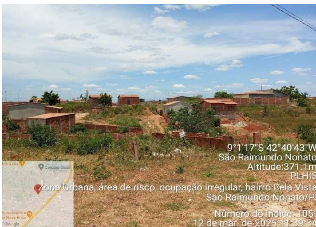
Foto 26 - Residências em área de risco e ocupação irregular, no bairro Bela Vista/01. Fonte: Autores do PLHIS (2025).
