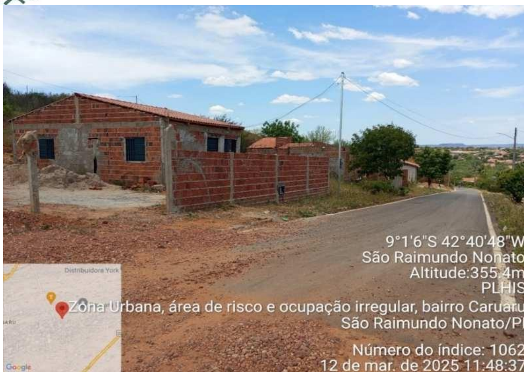
Foto 41 - Residências em área de risco e ocupação irregular, no bairro Caruaru/03. Fonte: Autores do PLHIS (2025).
