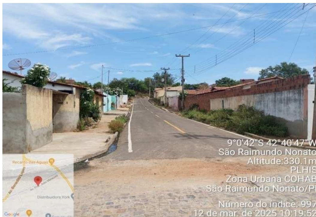
Foto 15 - Conjunto Habitacional COHAB, com ruas de pavimentação asfáltica e com blocos de pedra. Fonte: Autores do PLHIS (2025).
