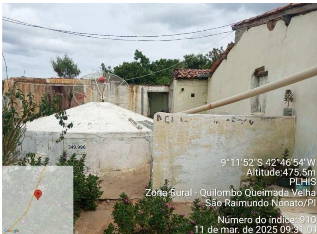
Foto 66 – Residência com Cisterna Telhadão para captação e reservação de água. Fonte: Autores do PLHIS (2025).
