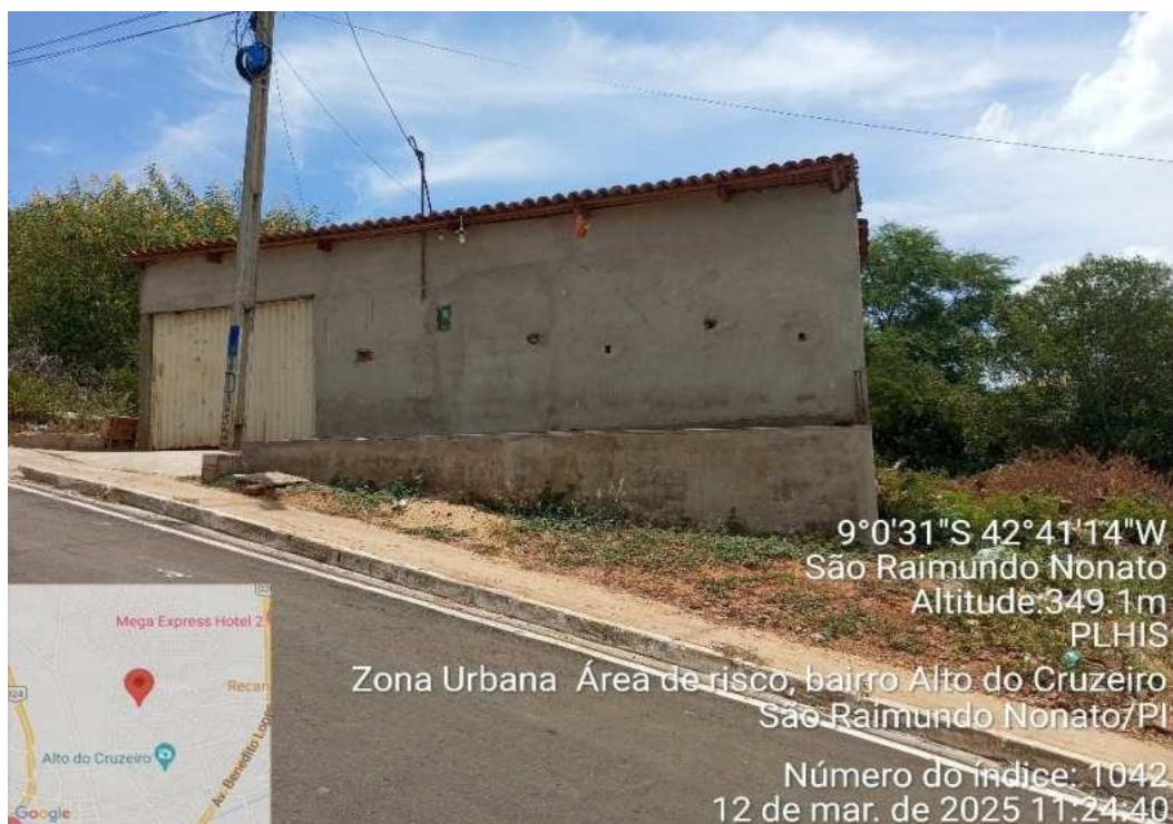
Foto 31 - Casa construída em área de risco, no bairro Alto do Cruzeiro/02. Fonte: Autores do PLHIS (2025).
