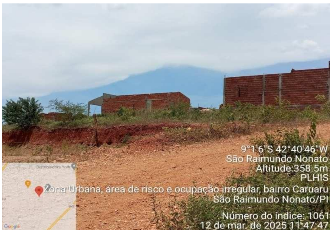
Foto 40 - Residências em área de risco e ocupação irregular, no bairro Caruaru/02. Fonte: Autores do PLHIS (2025).
