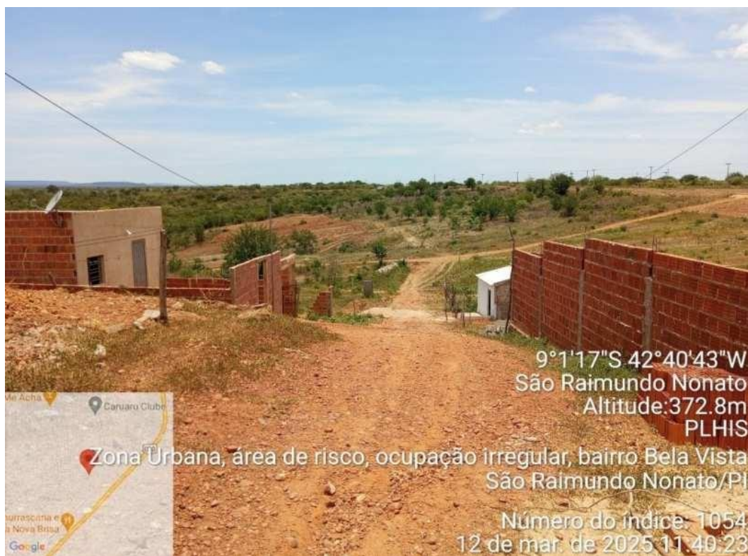
Foto 28 - Residências em área de risco e ocupação irregular, no bairro Bela Vista/02. Fonte: Autores do PLHIS (2025).
