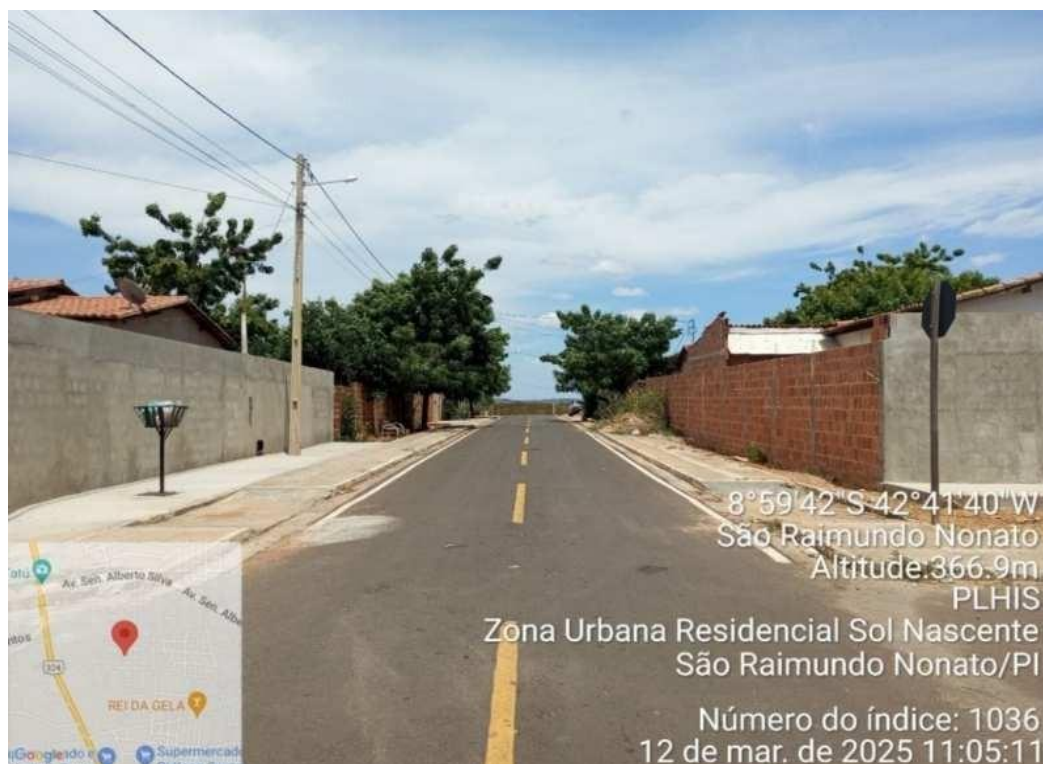
Foto 23 – Residencial Sol Nascente, ruas com pavimentação asfáltica. Fonte: Autores do PLHIS (2025).
